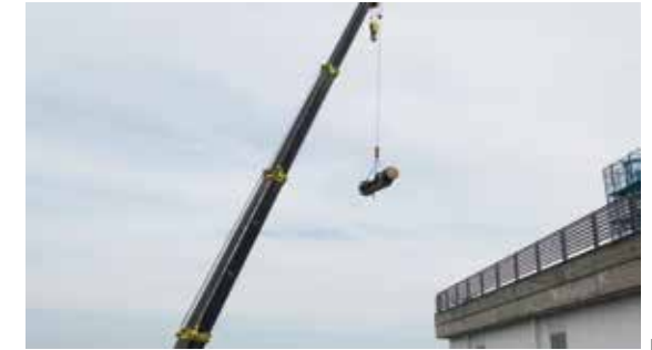
クレーン作業
