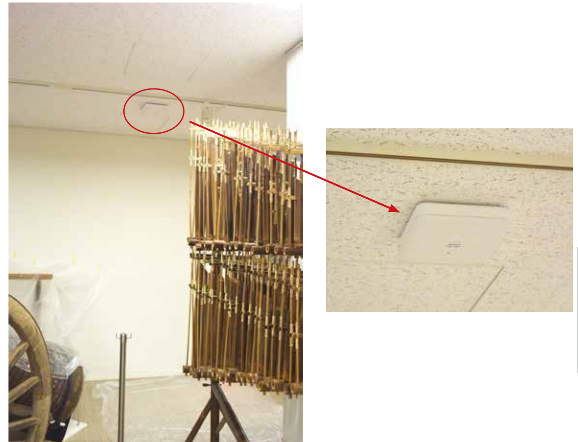
写真1：展示室アクセスポイント追加工事風景
