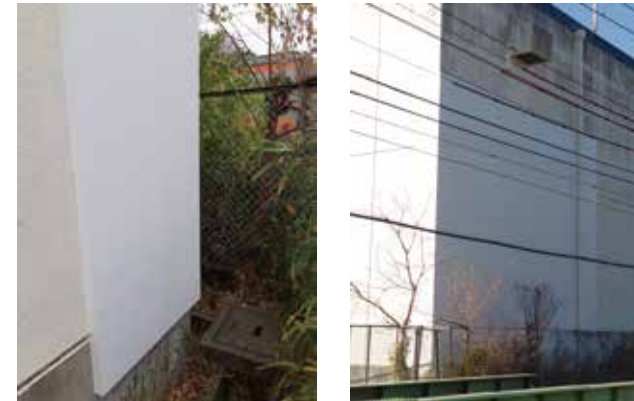
図4：工事後の倉庫外壁 断熱材追加部分が白く盛り上がっている。 （左図については倉庫ご担当者が撮影）
